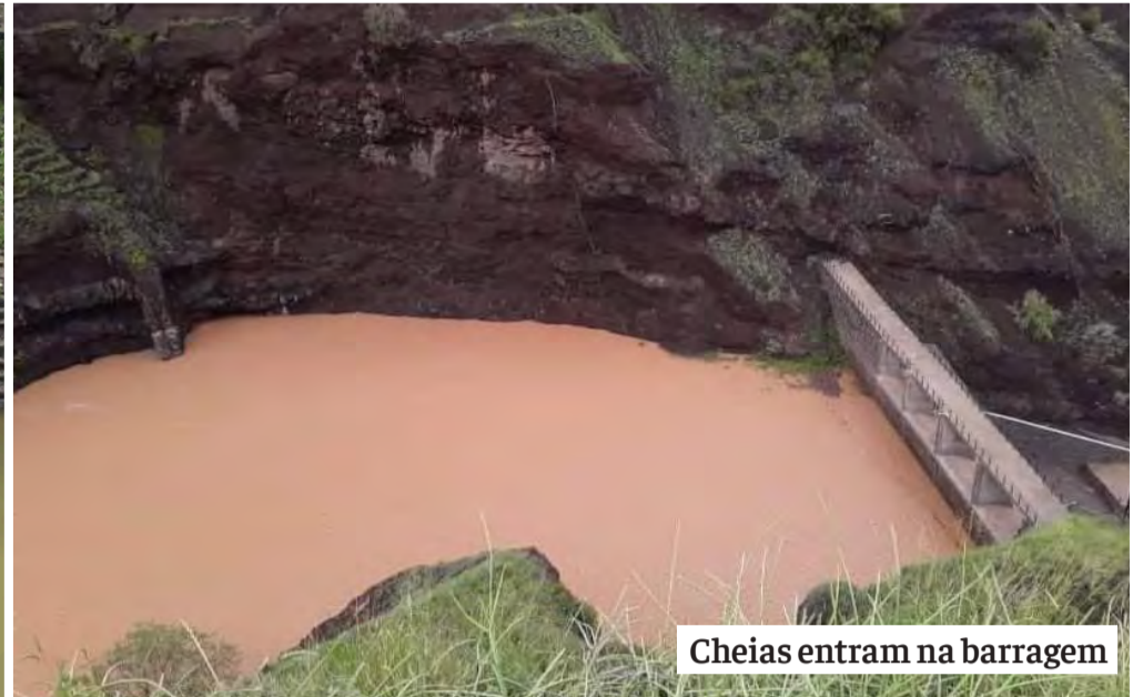
Barragem Canto de Cagarra
