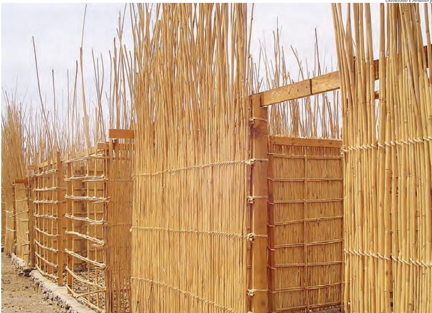
Casa em construção na comunidade dos Rabelados, em Espinho Branco
