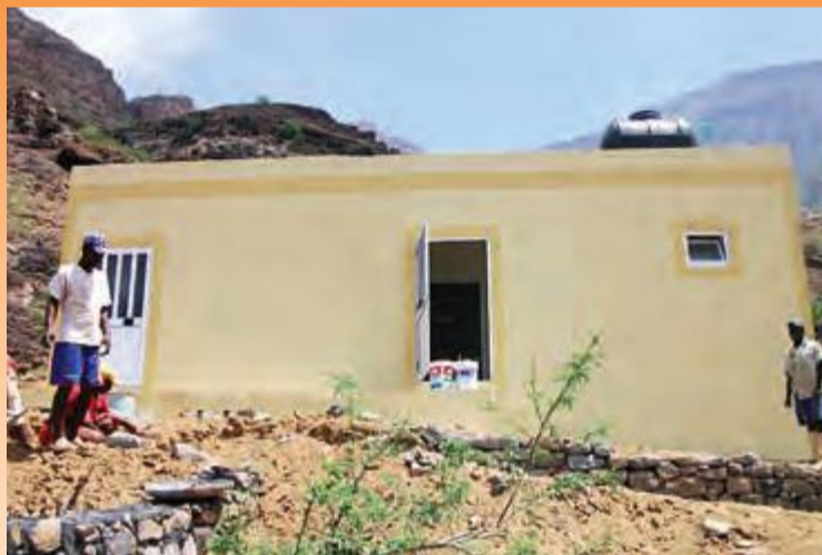
Casa Técnica da Central Fotovoltaica
